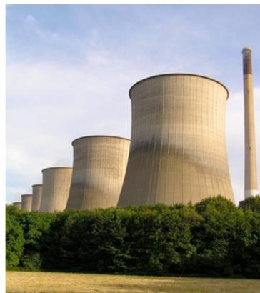
Kühltürme des Kraftwerks Gelsenkirchen-Scholven. Um die Flächenspannung zu minimieren, werden Kühltürme meist in Form (der unteren Hälfte) eines Katenoids gebaut.
